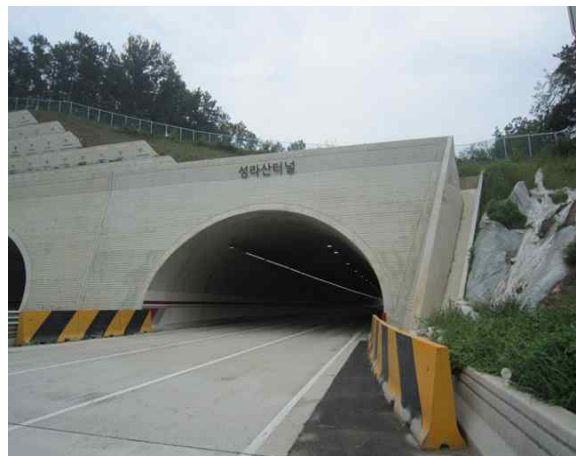
1공구 성라산터널(서울) 종점부
