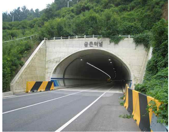
4공구 금촌터널(서울) 종점부
