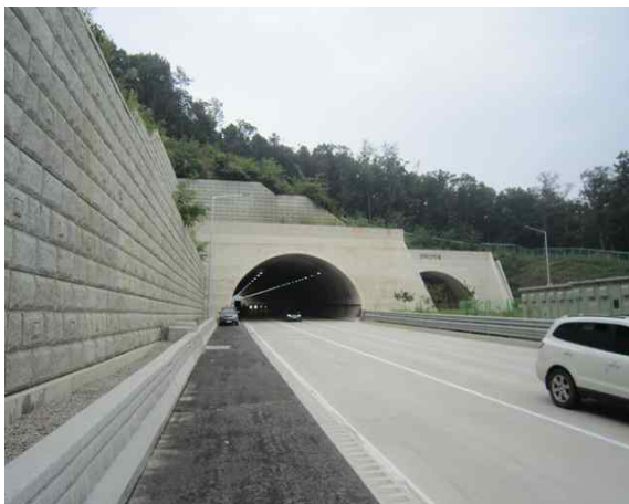
1공구 성라산터널(서울) 시점부
