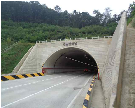
3공구 견달산터널(문산) 시점부
