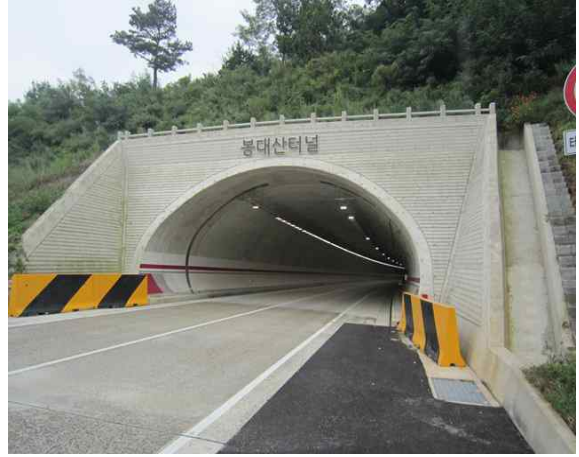
1공구 봉대산터널(서울) 종점부
