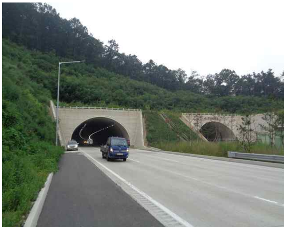
3공구 견달산터널(서울) 시점부
