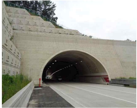
1공구 성라산터널(문산) 종점부
