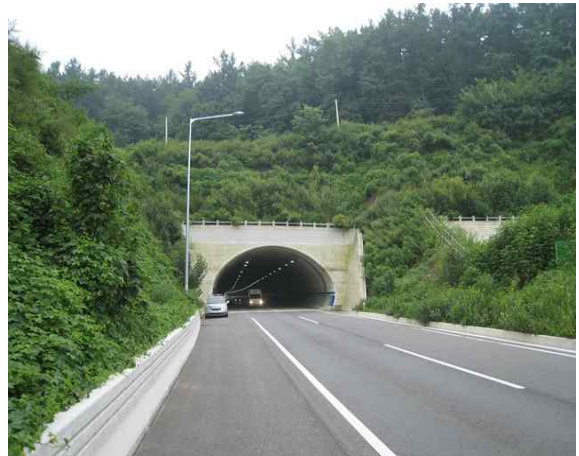
4공구 금촌터널(문산) 종점부
