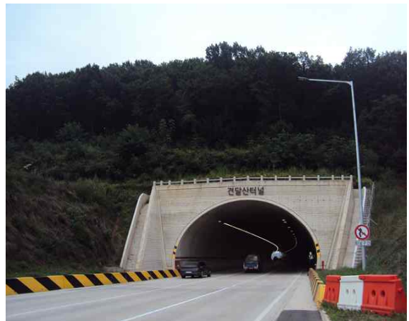
3공구 견달산터널(서울) 종점부
