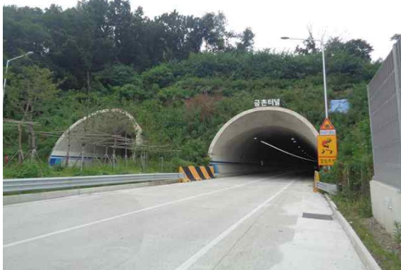
4공구 금촌터널(문산) 시점부
