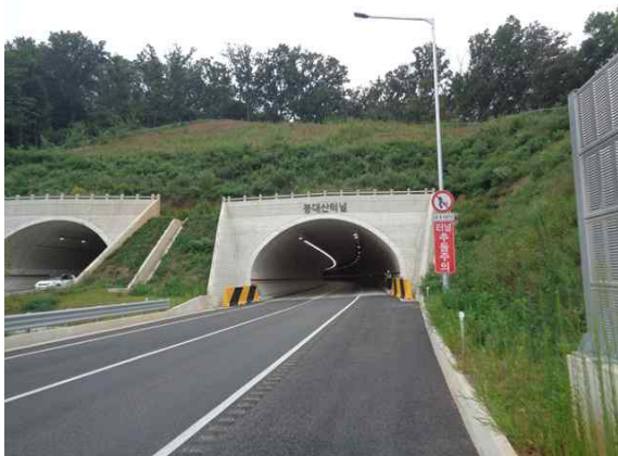
1공구 봉대산터널(문산) 시점부
