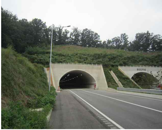
1공구 봉대산터널(서울) 시점부
