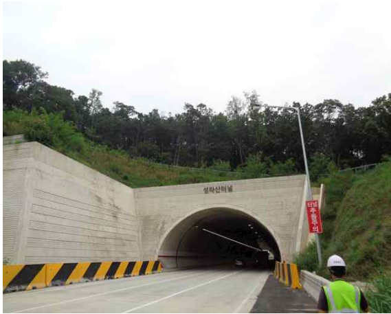
1공구 성라산터널(문산) 시점부
