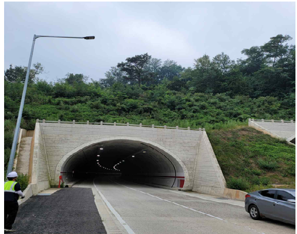
1공구 봉대산터널(문산) 종점부
