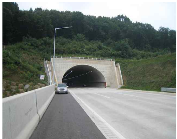
3공구 견달산터널(문산) 종점부
